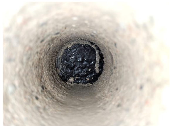
Kellarin kattilahuoneen maanpaineseinä.
