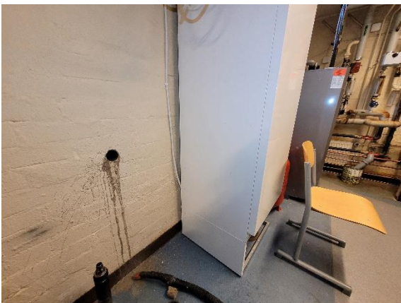
Kellarin kattilahuoneen maanpaineseinä.
