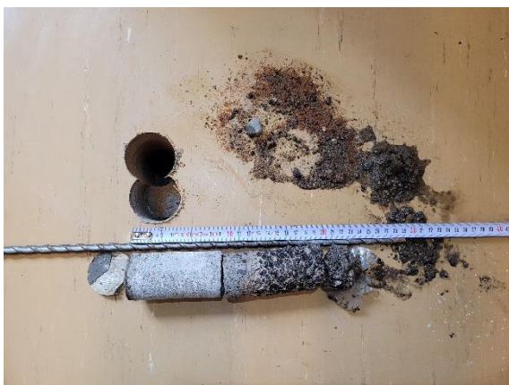
Kemian luokan varaston alapohja.
