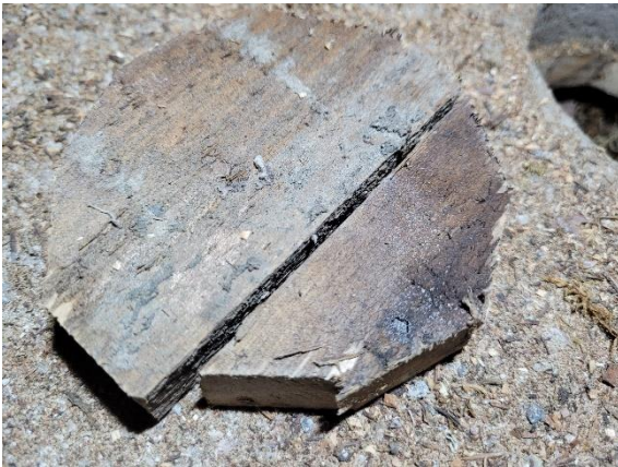
Muottilaudassa on silmin havaittavaa pintamikrobikasvustoa.
