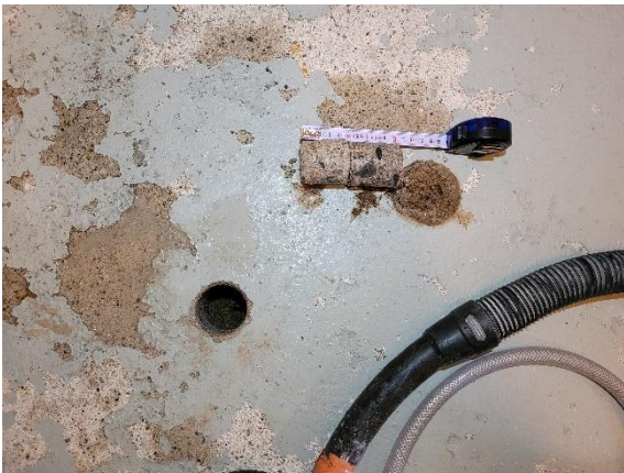
Kellarin porrashuoneen alapohja.
