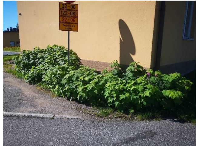
Kasvillisuutta liian lähellä sokkeliä
