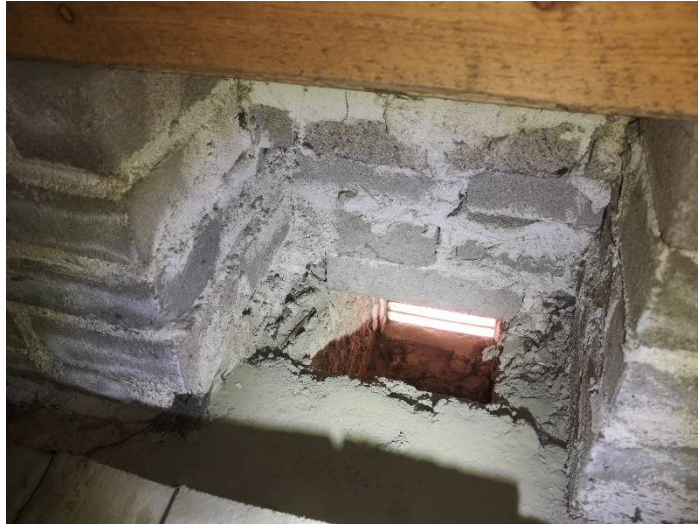
Ulkoseinä muurattu betonitiilistä
