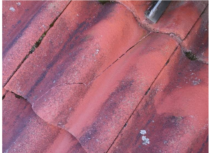
Tiiliä halki kattosillan kohdalla
