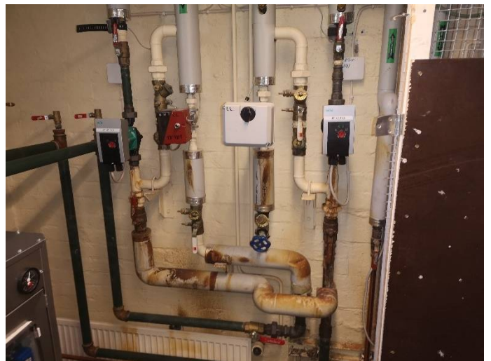
Lämmitysputkissa/liitoksissa ruostetta/hapettumaa
