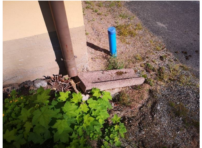
Kattosadevedet johdettu oikealla etunurkalla loiskekivellä kadulle
