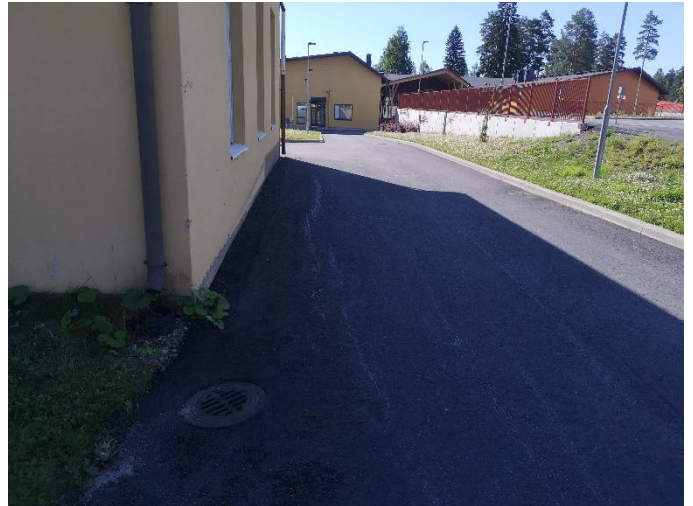
Asfaltointi viettää rakennuksesta poispäin
