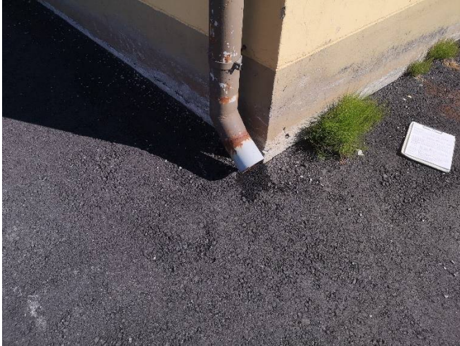
Kattosadevedet johdettu asfaltille
