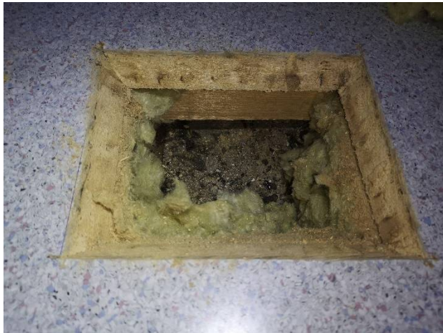
Luokan 203 lattian rakenneavaus
